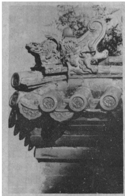
图 2-5 故宫内的墙帽转角，墙帽正脊扣脊瓦下用三连砖，兽头前不置仙人。
