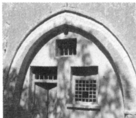
图 3 陇东窑洞的砖拱
