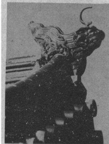
图9 故宫某建筑正脊端置兽头
